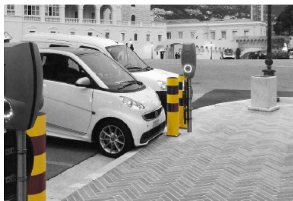
Figure 6: Exemple de protection d'un point de recharge 19
