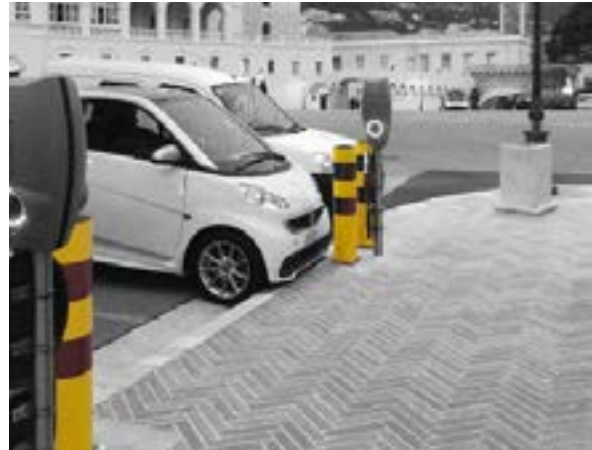
Figure 5: Exemple de protection d'un point de charge 19 .
