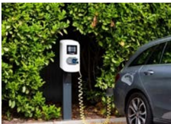
Figure 4: En haut, wallbox avec câble fixe, ci-dessous, modèle sur pied avec câble libre 15 .
